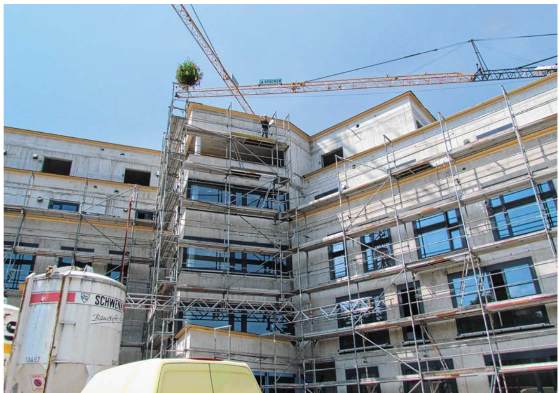
Den Richtspruch für das neue »Seniendomizil am Hewen« sprach Projektleiter Markus Kaltenstadler von der Firma Stocker. Die gute Erreichbarkeit, ausreichend Grundfläche mit 5.800 Quadratmetern in zentraler Lage und die flache Topographie waren im Vorfeld entscheidend für die Standortwahl. Die Fertigstellung des Gebäudekomplexes ist für Ende 2019/Anfang 2020 geplant. Architekt Wolfgang Graf sprach gegenüber dem HegauKurier von einer derzeitigen Punktlandung hinsichtlich der Bauzeit und der Kosten. Bild: Hering
